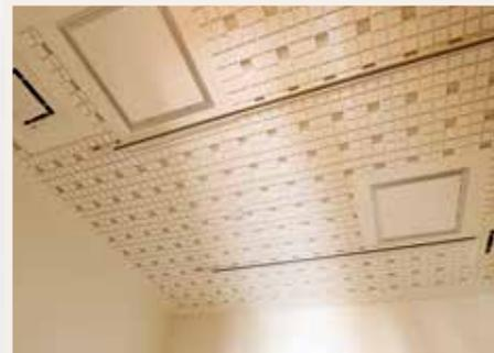
天井はデザイン性もあり吸音・防音に優れた DAIKEN の「オトテン」を採用。壁は複層構造の防音壁で、ドアも防音仕様です。酸欠防止のための吸排管も備えています。
