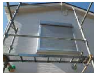
足場設置の様子
