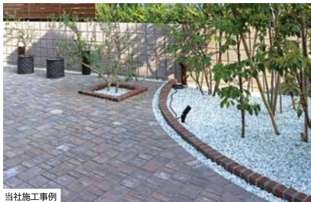
当社施工事例 エスビック パエリア
