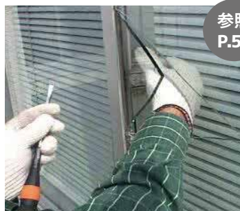
露出配線の施工事例
