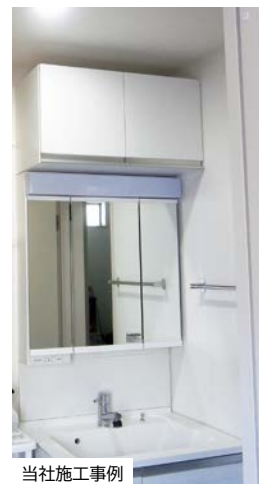
当社施工事例
