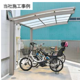
当社施工事例
