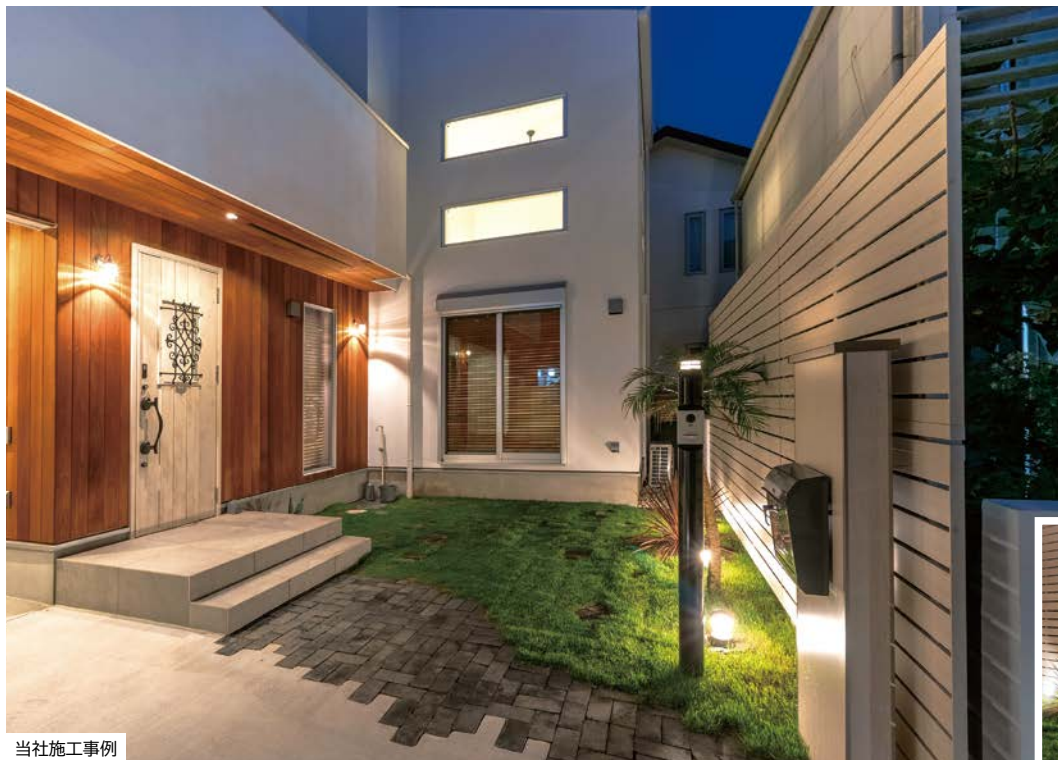
当社施工事例
