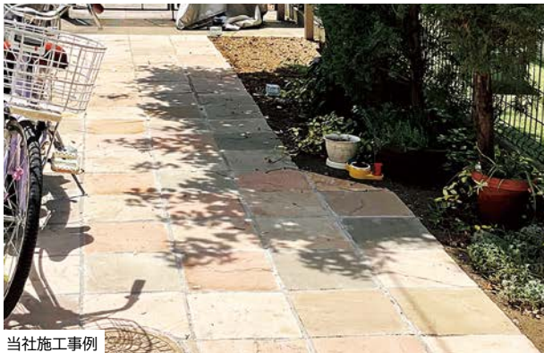
当社施工事例 エスピック ラジャスターン方形
