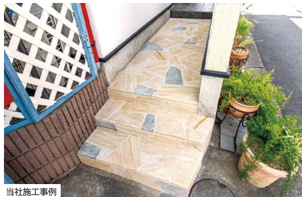
当社施工事例 ローラーストーン
