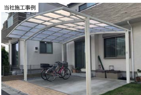
当社施工事例
