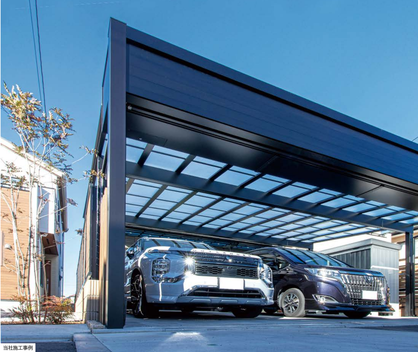
当社施工事例
