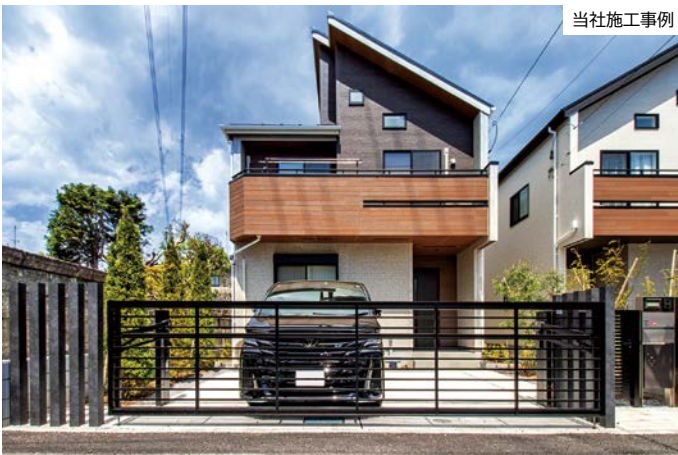
当社施工事例
