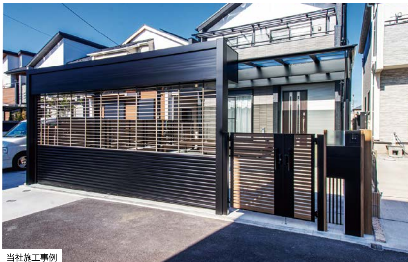
当社施工事例
