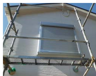
足場設置の様子
