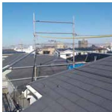
玄関アプローチには滑り止めを、屋根には転落防止の親網を取り付けています
