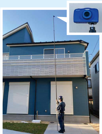
屋根の上に登らず 点検棒で安全点検
